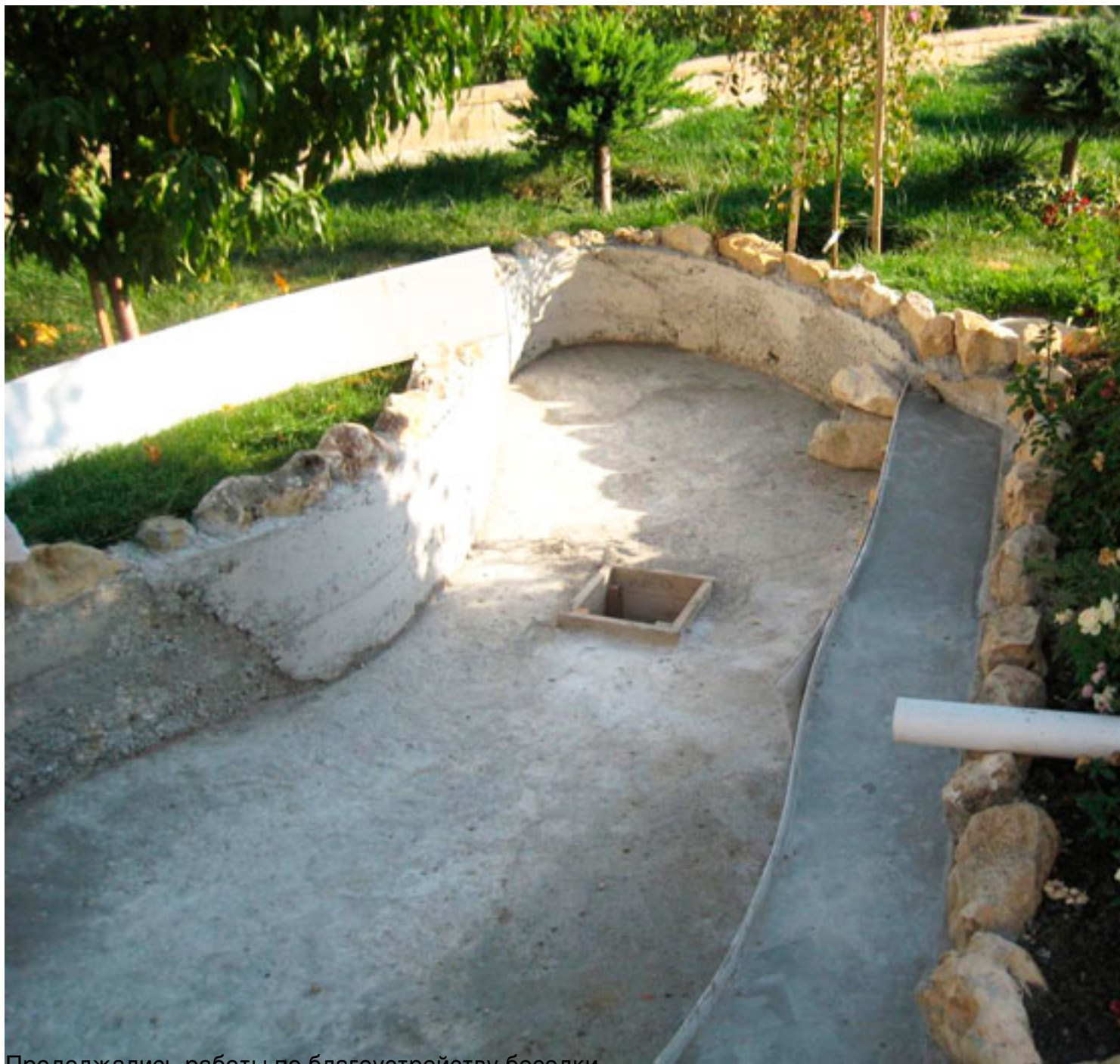
Продолжались работы по благоустройству беседки.
