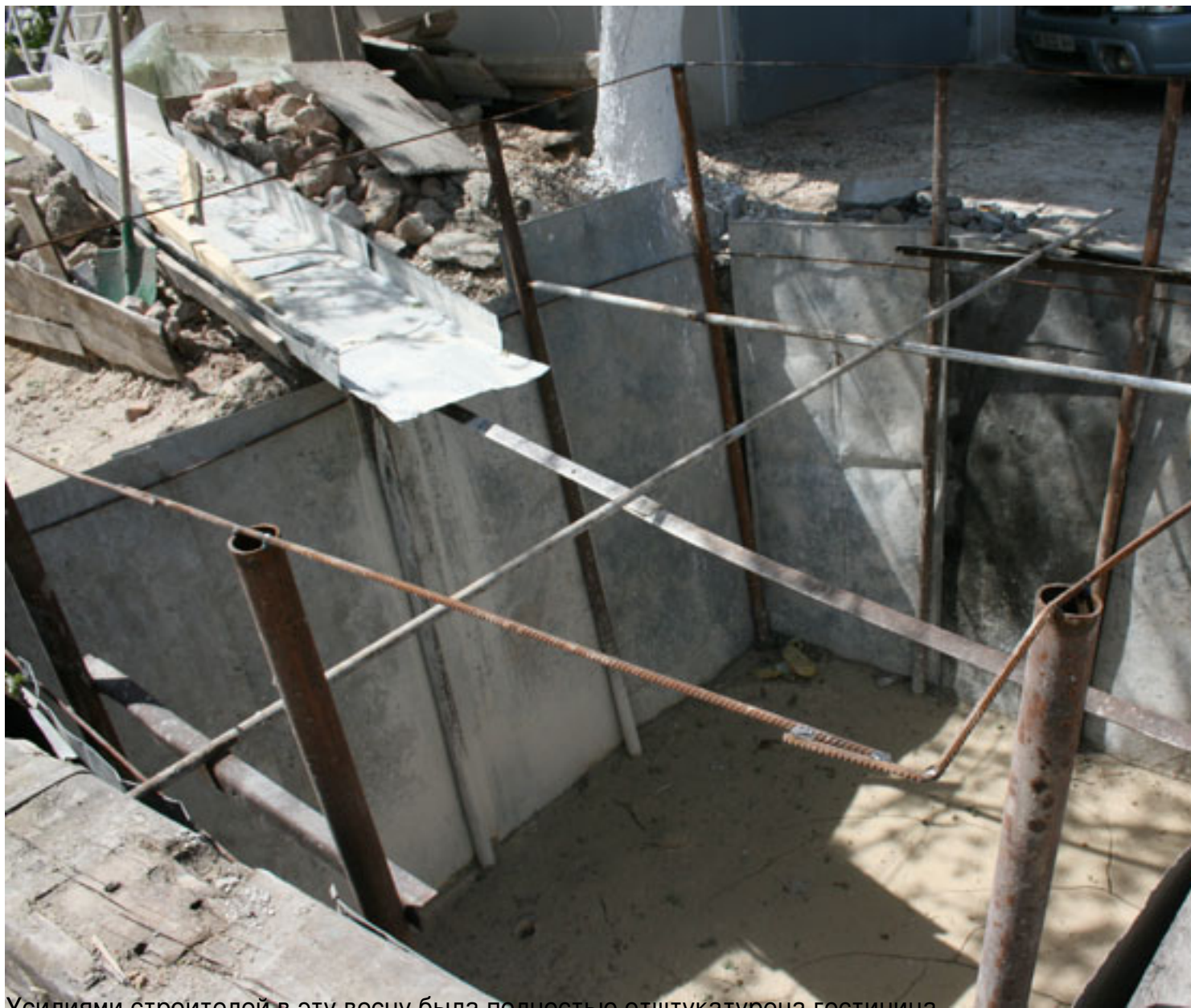
Усилиями строителей в эту весну была полностью отштукатурена гостиница.
