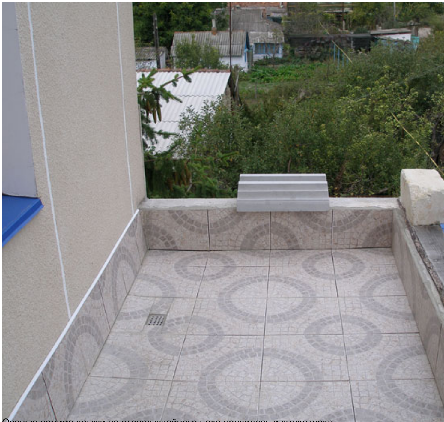
Осенью помимо крыши на стенах швейного цеха появилась и штукатурка.
